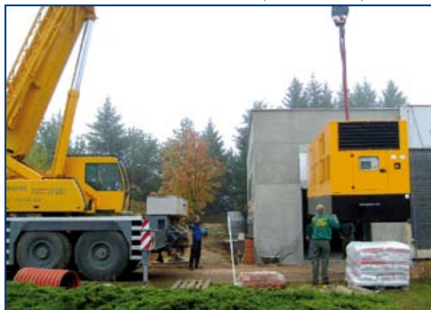
Nový motorgenerátor jako záložní zdroj ▼ pro Centrální operační sály
